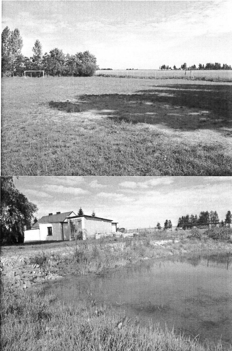
Rysunek nr 27. Dokumentacja fotograficzna – stan techniczny boiska w Starej Kakawie
