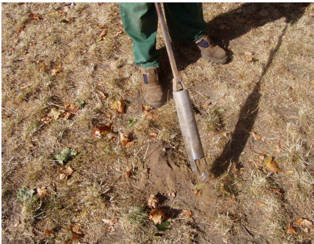
Wykonywanie odwiertów (nr 4)
