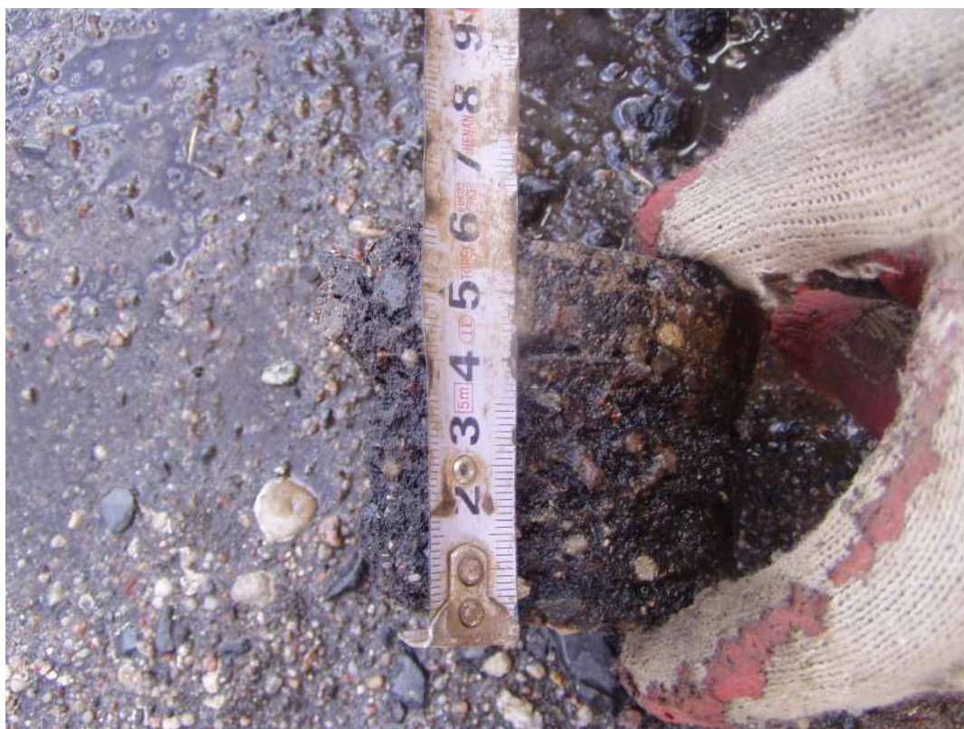
Wykonywanie odwiertów (nr 6) Nawierzchnia bitumiczna gr. 6cm
