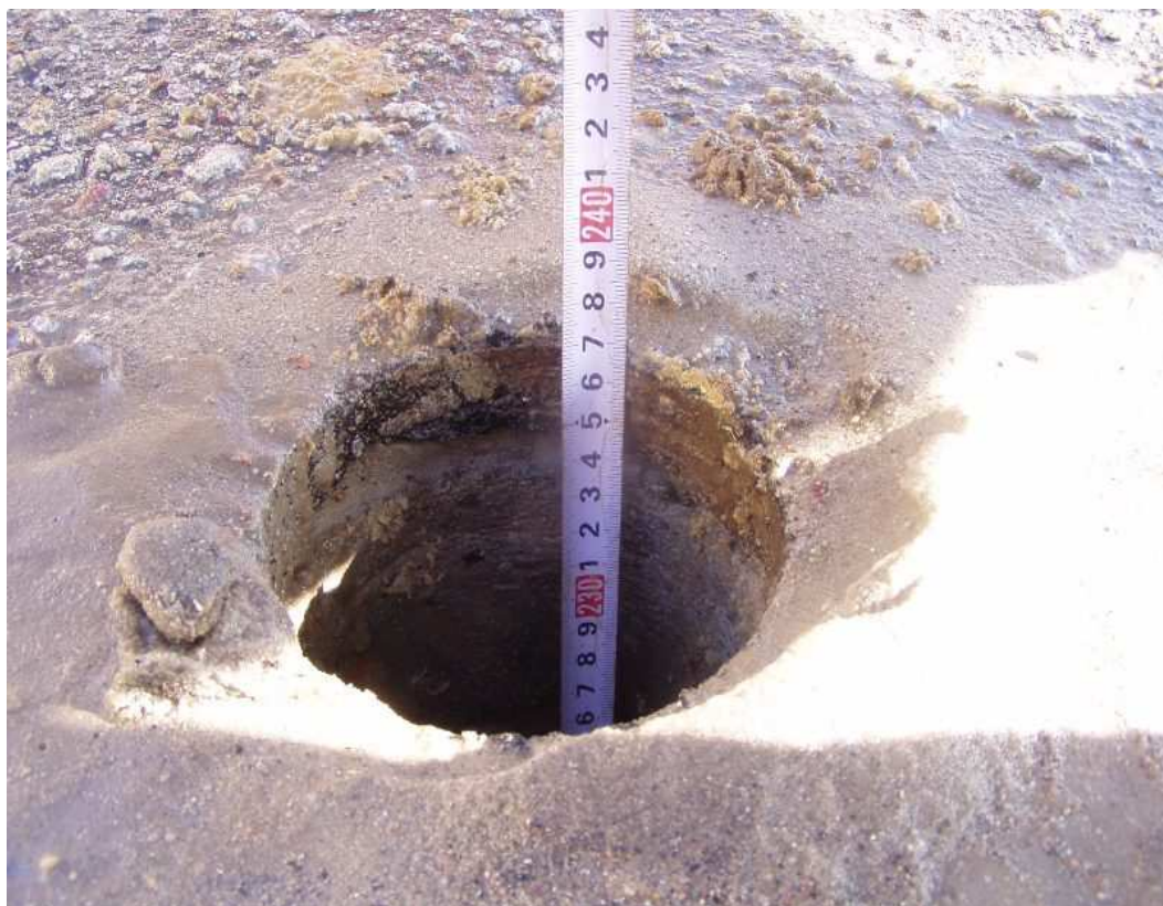
Wykonywanie odwiertów do głębokości 235cm p.p.t
