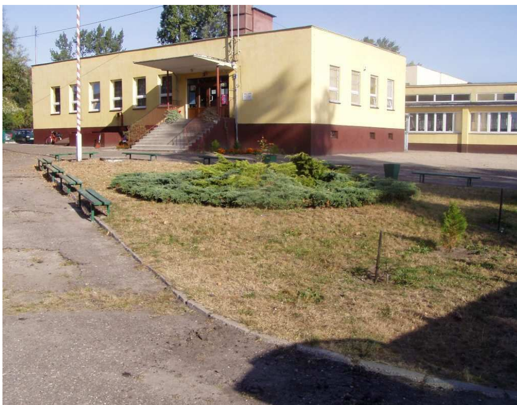
Istniejące zagospodarowanie terenu przed budynkiem Zespołu Szkół nr 1 w Godzieszach Wielkich
