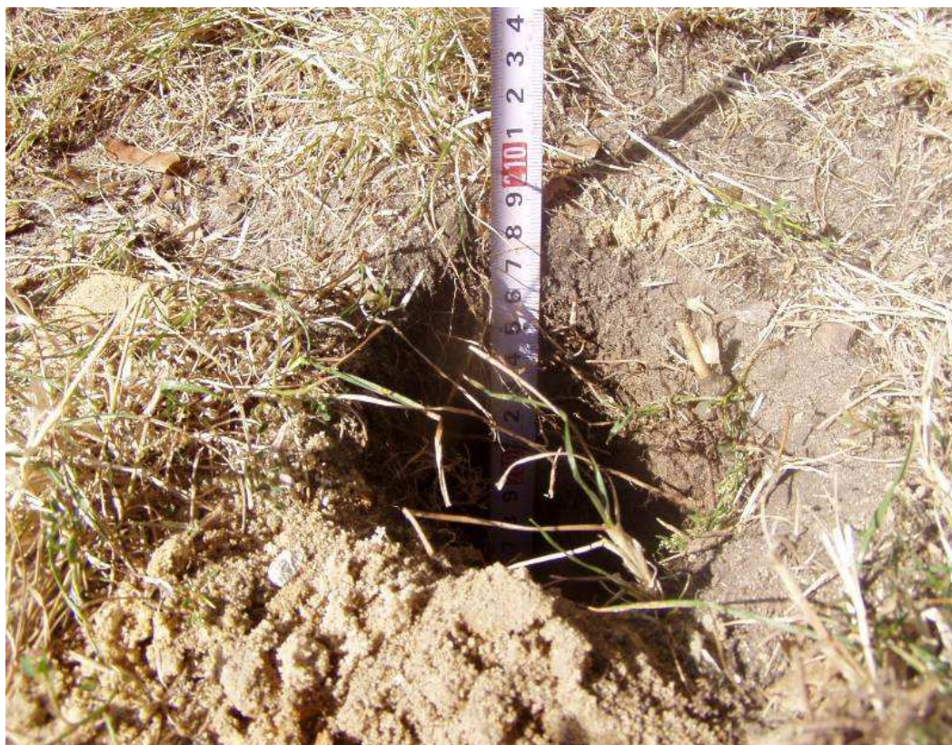
Wykonywanie odwiertów (nr 4) do głębokości 210cm p.p.t
