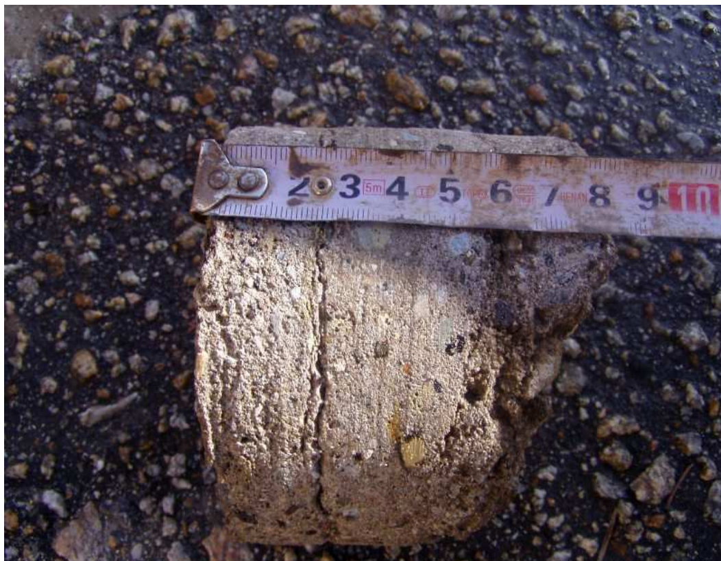
Wykonywanie odwiertów Nawierzchnia bitumiczna gr. 7cm
