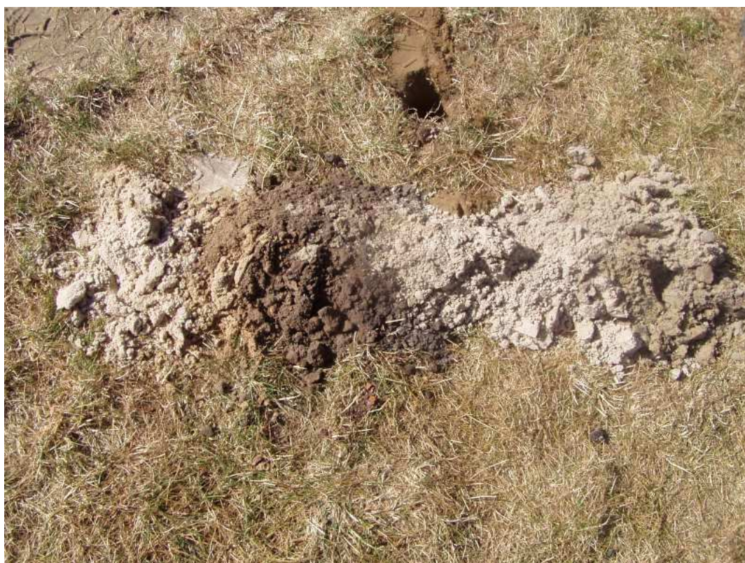
Wykonywanie odwiertów (nr 5)
