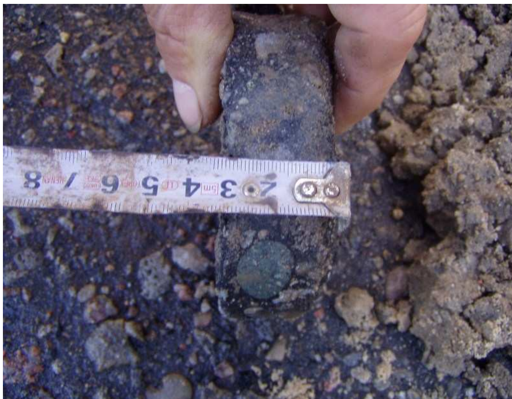
Wykonywanie odwiertów (nr 3)
