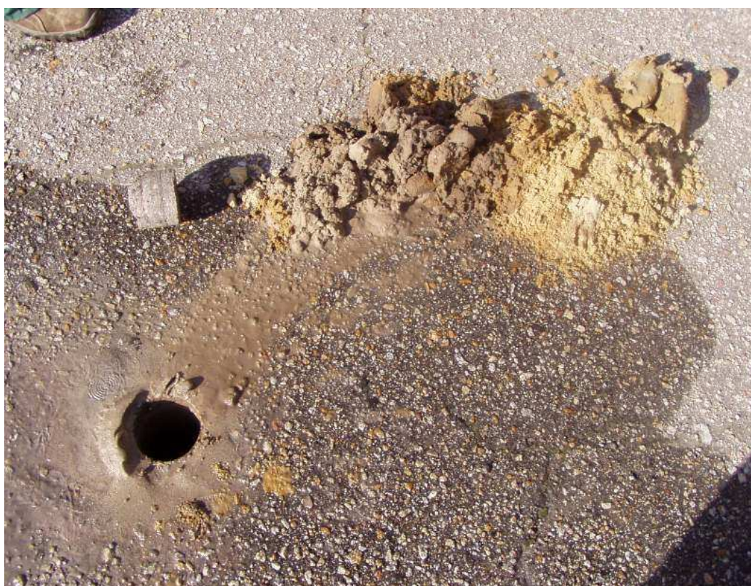
Wykonywanie odwiertów (nr 1)
