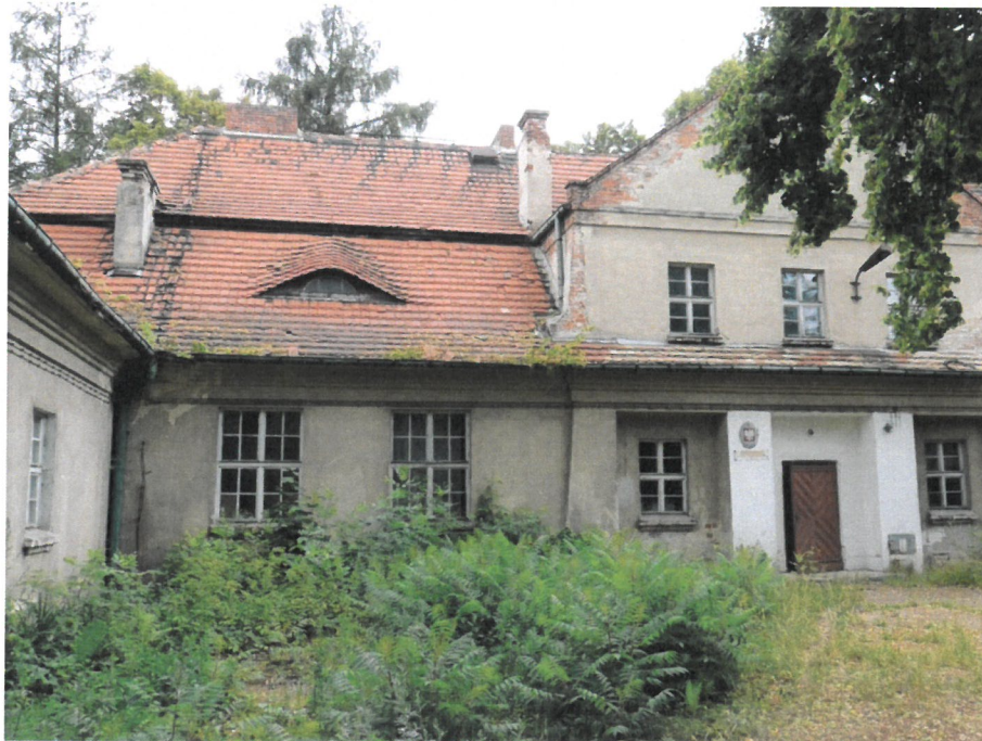
Rysunek nr 36. Dokumentacja fotograficzna – stan techniczny starej szkoły w Kakawie Kolonii
