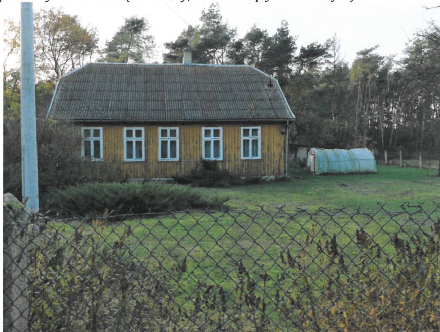
Rysunek nr 28. Dokumentacja fotograficzna –budynek poszkolny we wsi Biała (drewniany, z dachem z płyt eternitowych)
