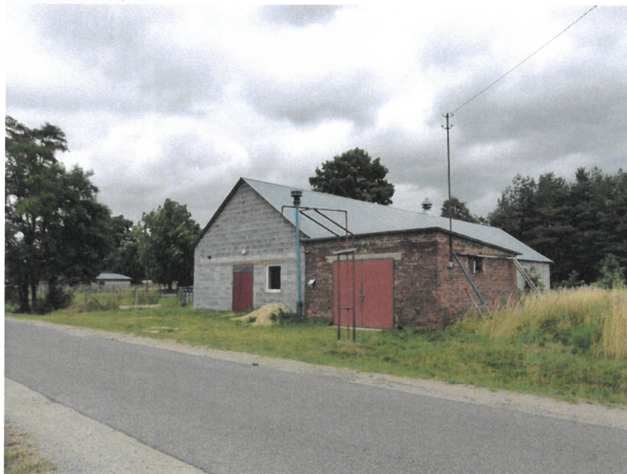
Rysunek nr 27. Dokumentacja fotograficzna – stan zewnętrzny remizy OSP w Kakawie-Kolonii
