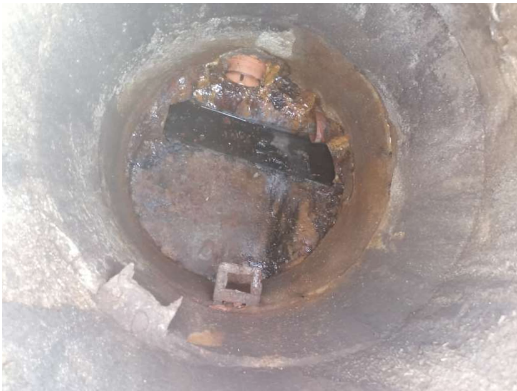
Studnia ul. Marii Konopnickiej przy posesji 21
