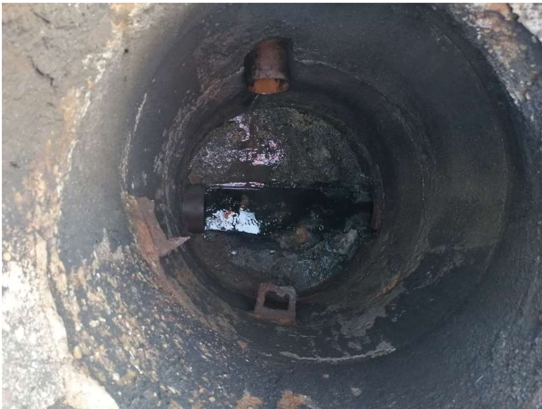
Studnia ul. Marii Konopnickiej przy posesji 23
