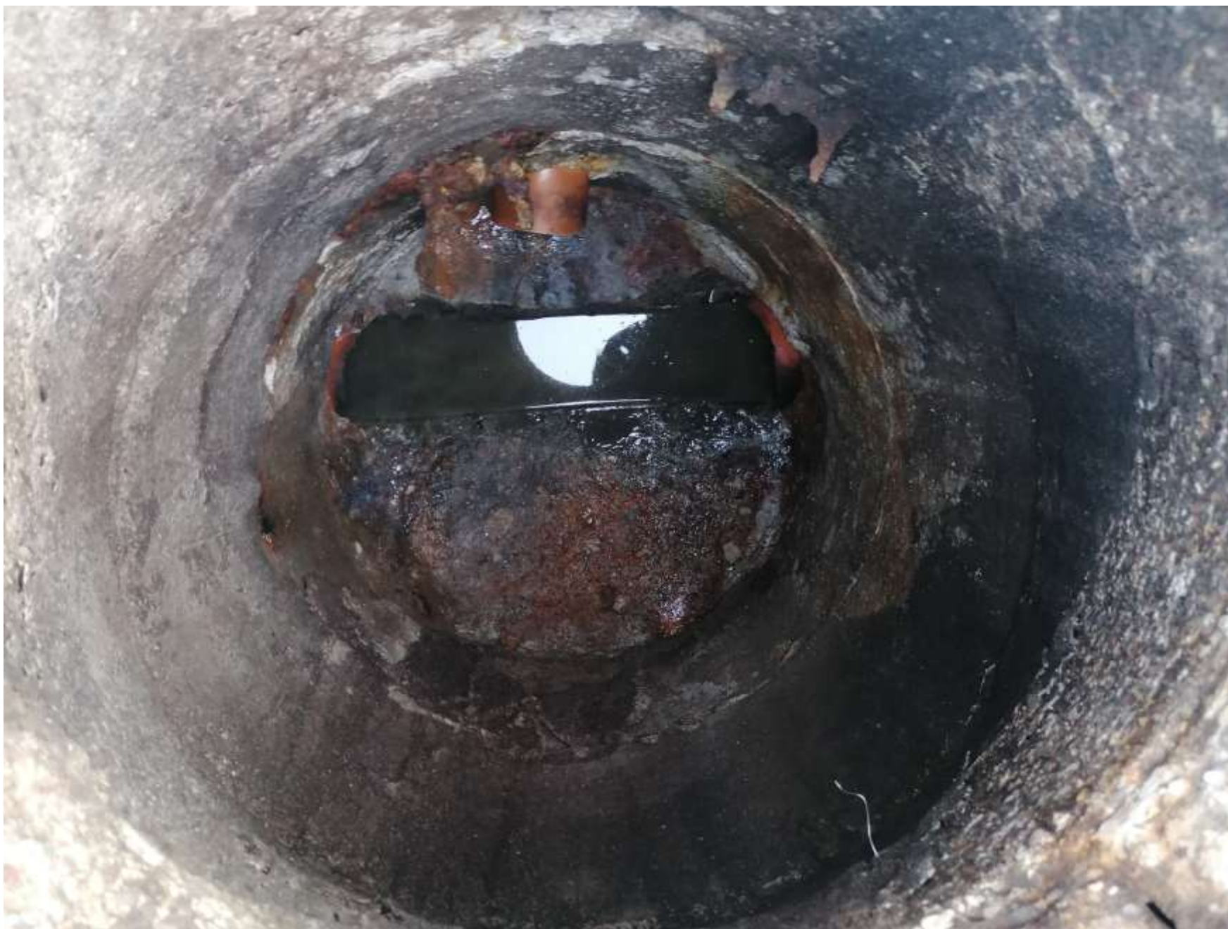
Studnia ul. Marii Konopnickiej przy posesji 20
